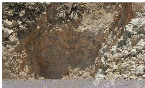
Slika 3.9 - Vertikalni pukotinski sustav pružanja 115-295
