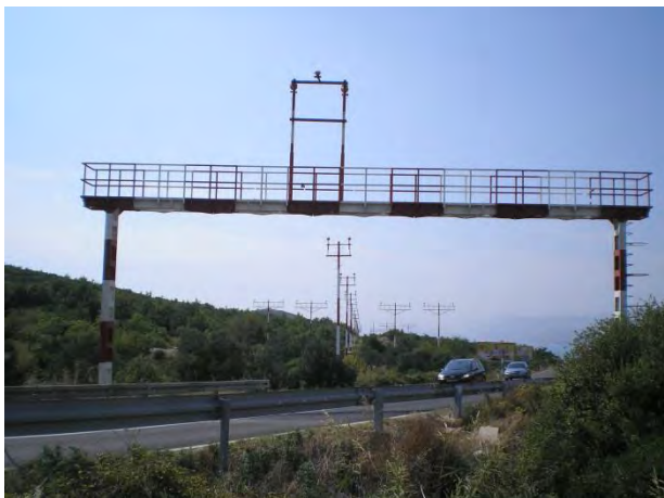
Slika 3.35 - Stupovi svjetlosne signalizacije zračne luke
